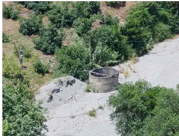
Slika 1. Na Kritu urađen kopani bunar u bujičnom zaplavu, a kaptirane podzemne vode se koriste u poljoprivredi za navodnjavanje (foto: R. Ristić)
