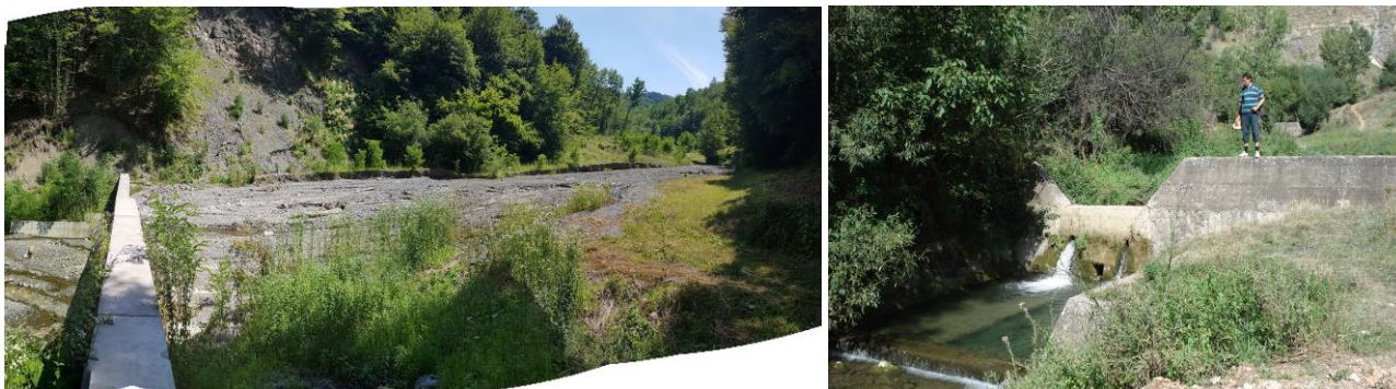
Slika 2. Bujična pregrada i moćan zaplav na Čadevici, sliv Jadr, zapadna Srbija [5] i Gradašničke reke, sliv Nišave, istočna Srbija (foto: Z. Nikić)
