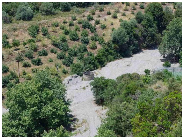
Slika 1. Na Kritu urađen kopani bunar u bujičnom zaplavu, a kaptirane podzemne vode se koriste u poljoprivredi za navodnjavanje (foto: R. Ristić)
